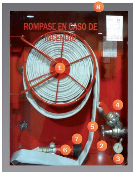
**4. RACOR:** Elemento de conexión que se usa para unir la manguera con la red fija de transporte de agua o, si es necesario, para realizar el empalme de dos mangueras.
